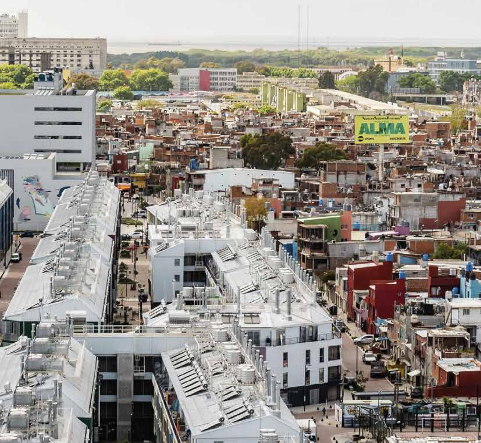
Se implementó la técnica constructiva del Steel-Frame, que permite aislar los sonidos y las temperaturas facilitando así el ahorro energético. Además, cuentan con paneles y termotanques solares que permiten aprovechar las energías renovables y reducir el consumo.
